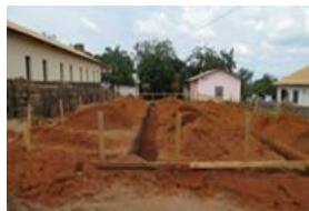
Début du chantier : à gauche ancien bâtiment
